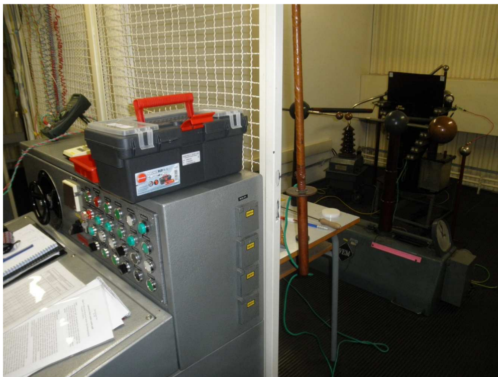
Obr. 6.2 Laboratoř vysokého napětí s přístrojovým vybavením
