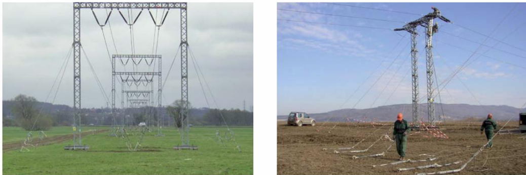
Obr. 15 110 kV NPT zajišťuje přenos po dobu odstávky vedení [26]
