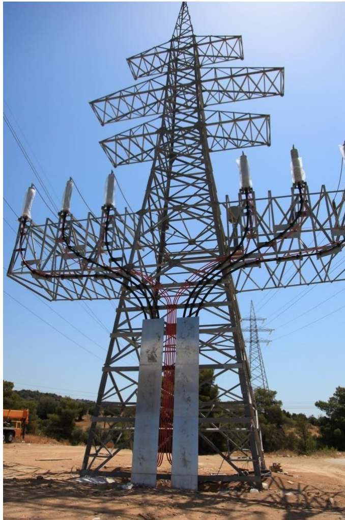
Obr. 12 Přechod mezi venkovním a kabelovým vedením [23]
