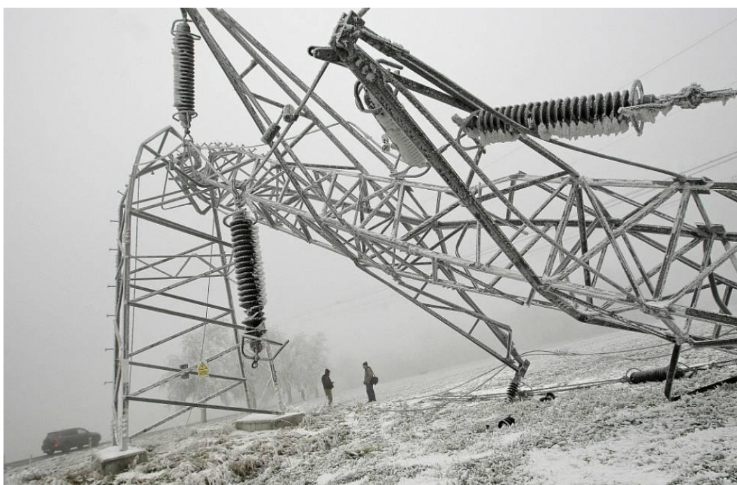
Obr. 16 Co dokáže námraza a vítr na vedení 110 kV [27]
