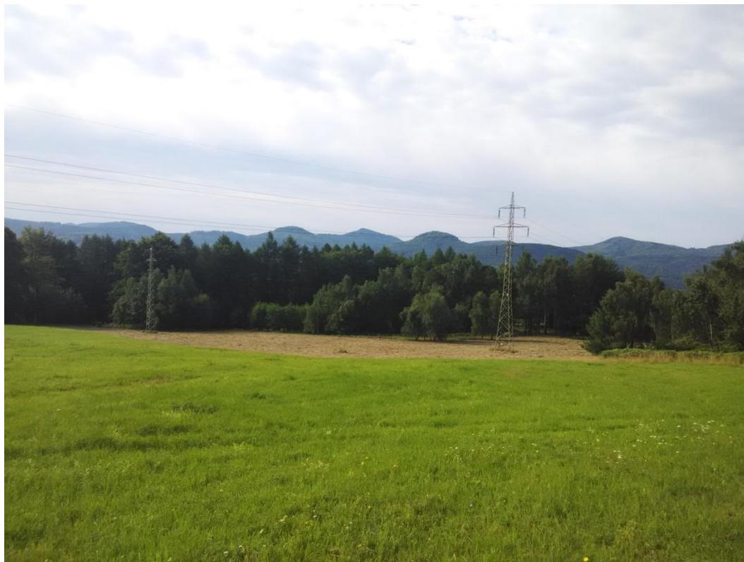
Souběh vedení 110 kV a 35 kV u obce Chřibská [autor]
