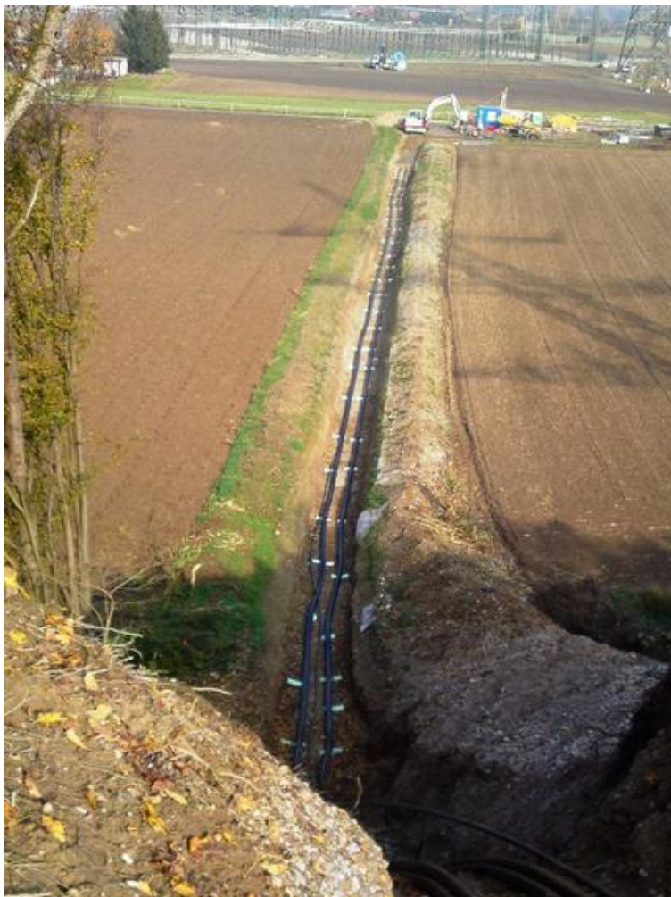
Obr. 7 Uložení VVN kabelů do země [18]
