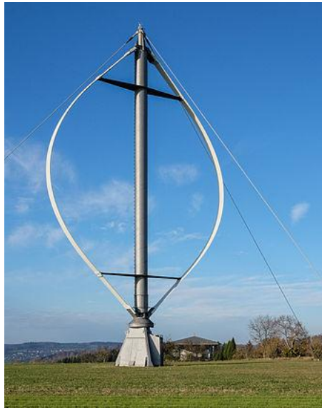
Obr. 2.10 Darrierův rotor ve tvaru pí [31]
