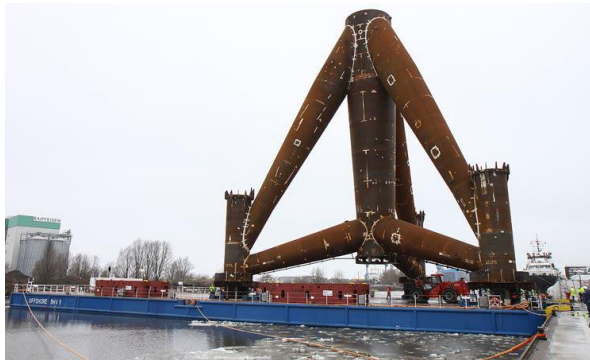
Obr. 3.4 Konstrukce typu tripod [35]
