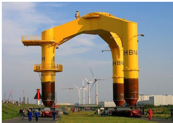
Obr. 3.5 Konstrukce typu tripile [36]
