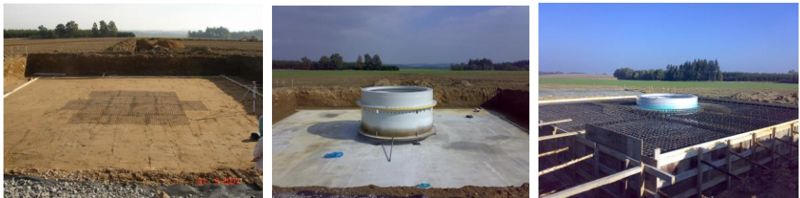
Obr. 2.17 Betonový základ větrné elektrárny [13]
