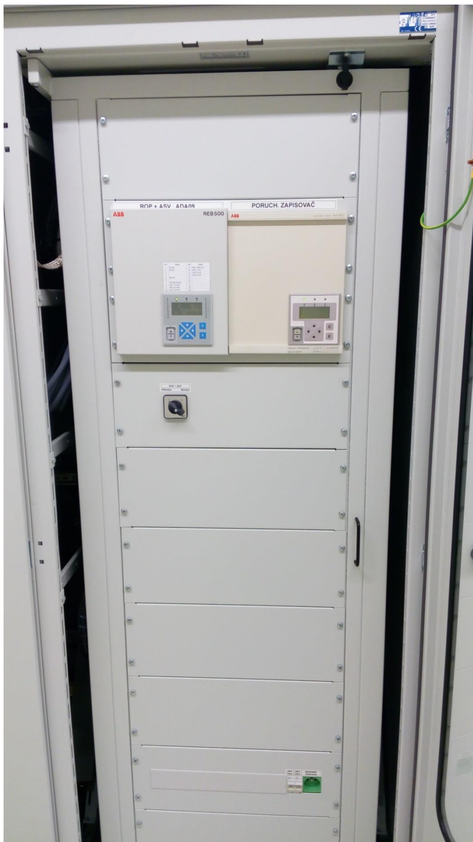
Obrázek A.2 Sestava rozváděče vývodové jednotky ROP
