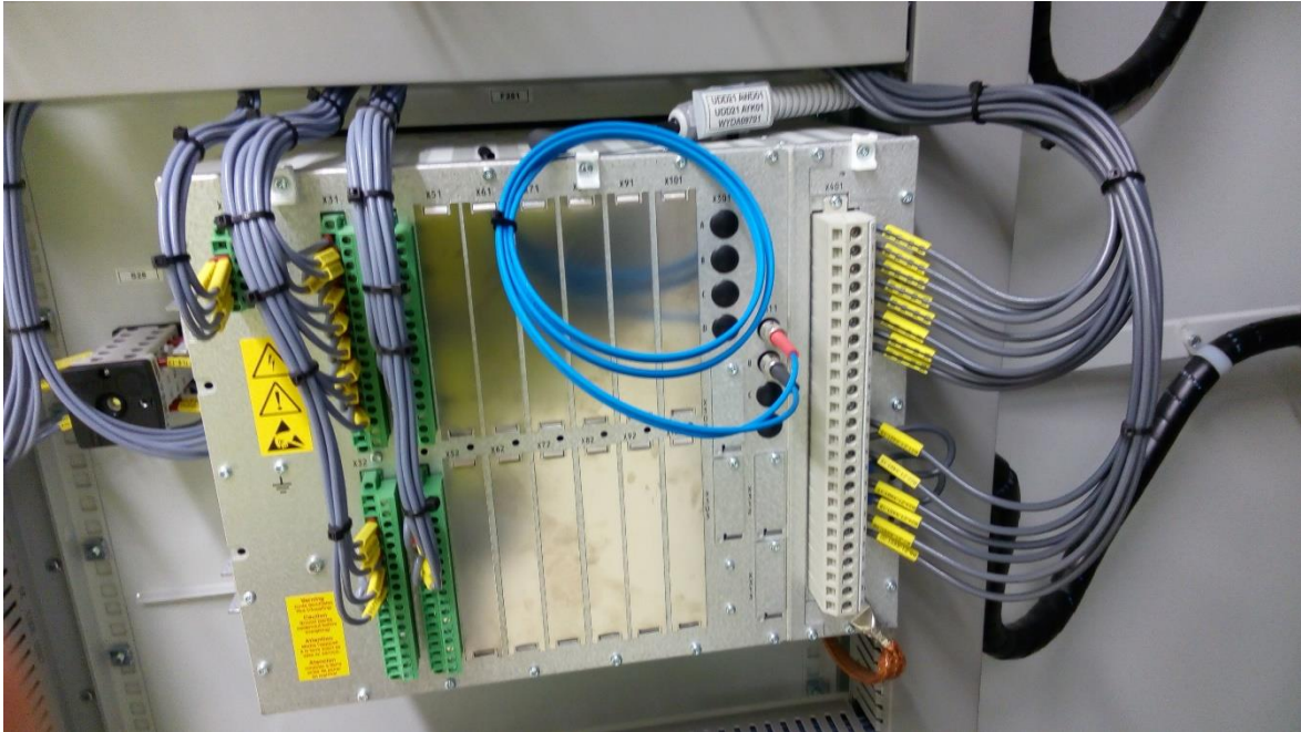
Obrázek A.3 Připojení proudových, napěťových vstupů a optického rozhraní do ochrany REL670
