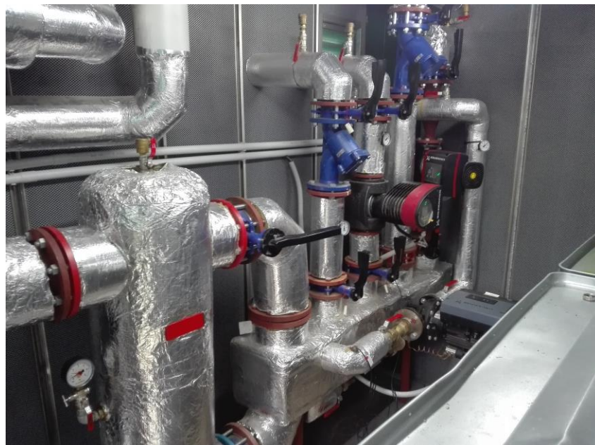
Obrázek 9: Výměňiková stanice v BPS Pšov, zdroj vlastní
