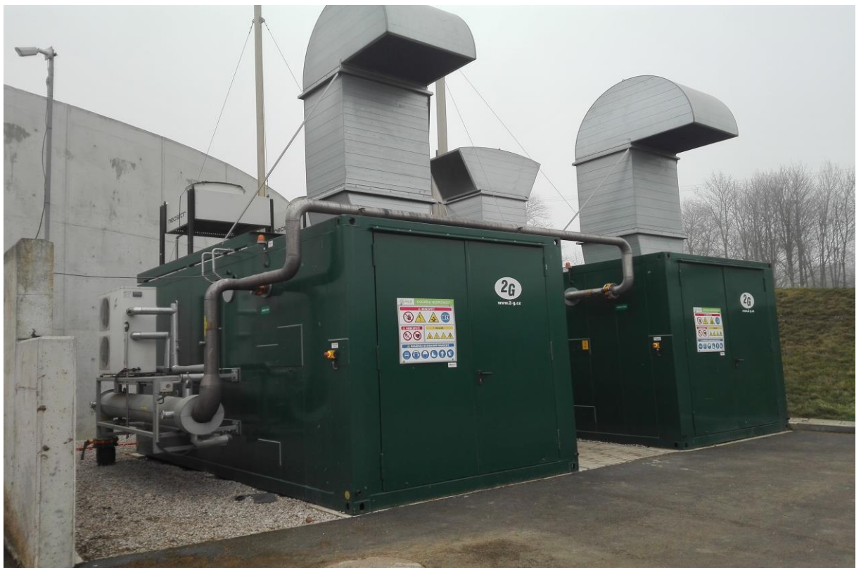
Obrázek 8: Kogenerační jednotky BPS Pšov, zdroj vlastní
