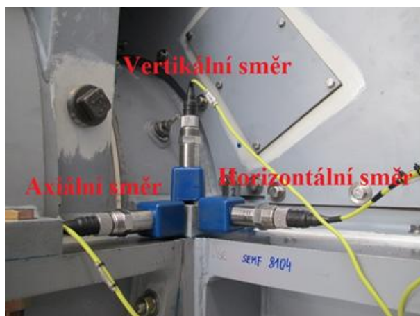
Obr. č. 62: Detail umístění snímačů vibrací na ložisku
