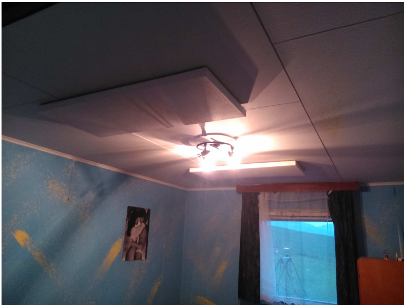
Obr. 13-6 Pohled na sálavé panely dětského pokoje od dveří
