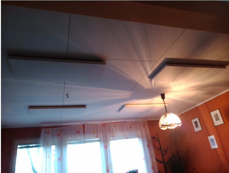
Obr. 13-5 Pohled na sálavé panely obývacího pokoje od dveří
