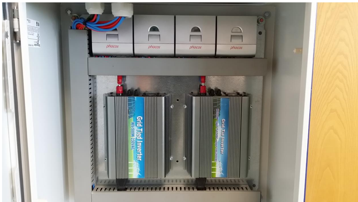
Obr. 3.2.5 Umístění nabíječů a střídačů v místnosti EL 205
