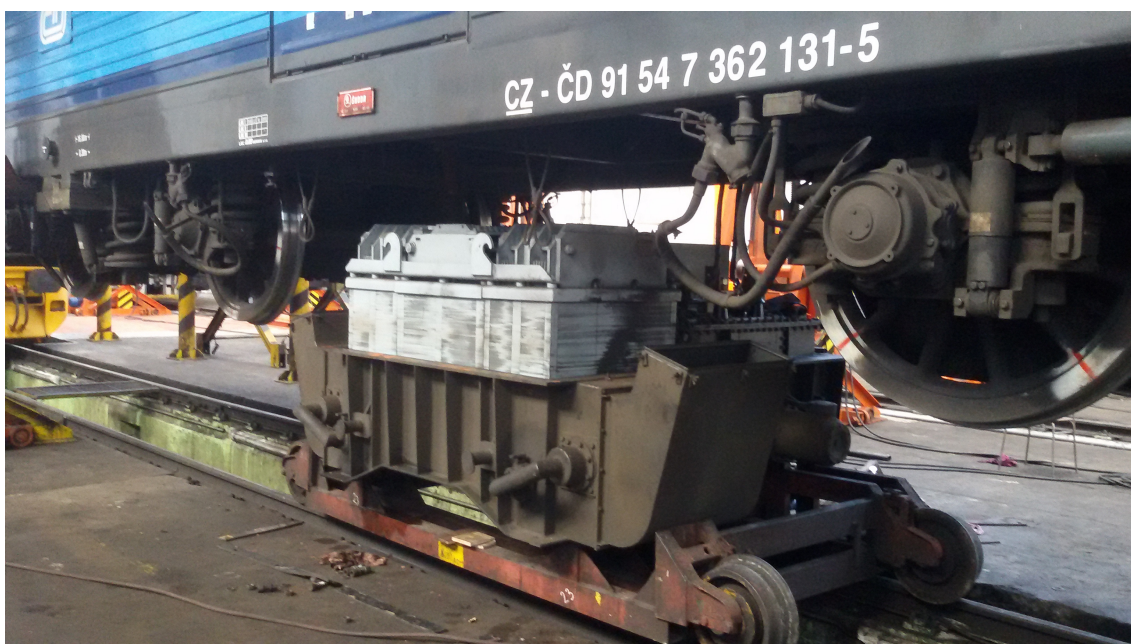
Obrázek 6.3: Vyvázaná nádoba obsahující tlumivky (vpředu) a trakční transformátor (vzadu). Jsou zde také vidět nástavce pro připojení k oběhu chladícího vzduchu u nádoby tlumivek a čerpadlo transformátorového oleje u nádoby transformátoru
