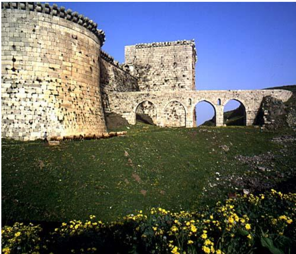
Ilustrace č. 12: Akvadukt
