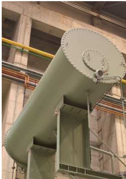
Obr. 1.7 Konzervátor s ukazatelem hladiny oleje pro hlavní nádrž (převzato z [6])
