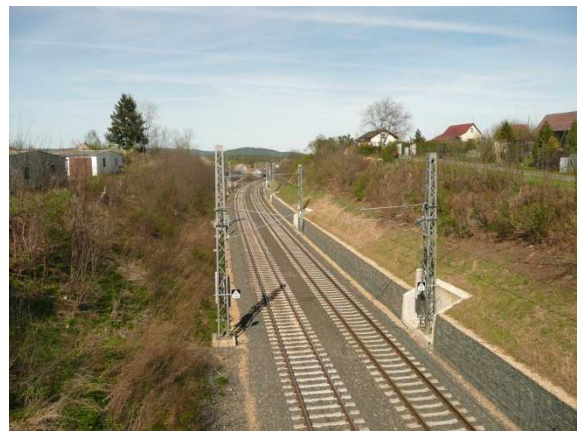
Obrázek P6_fotografie traťového úseku - zářez na trati
