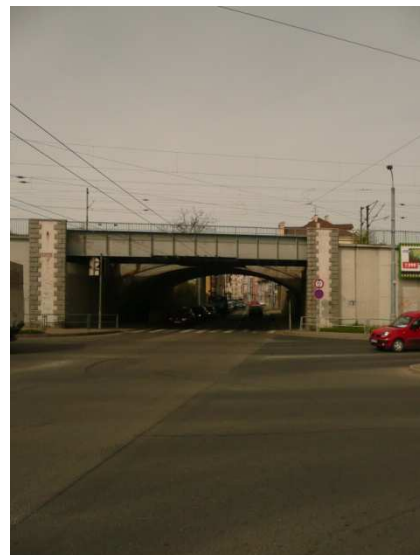
Obrázek P14_fotografie měřené trati - most1
