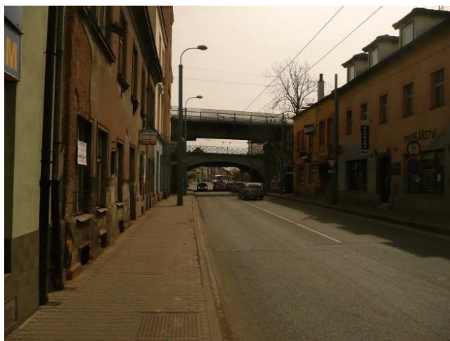
Obrázek P15_fotografie měřené trati - most1
