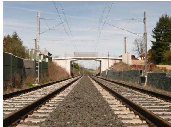
Obrázek P8_fotografie traťového úseku - most nad trati
