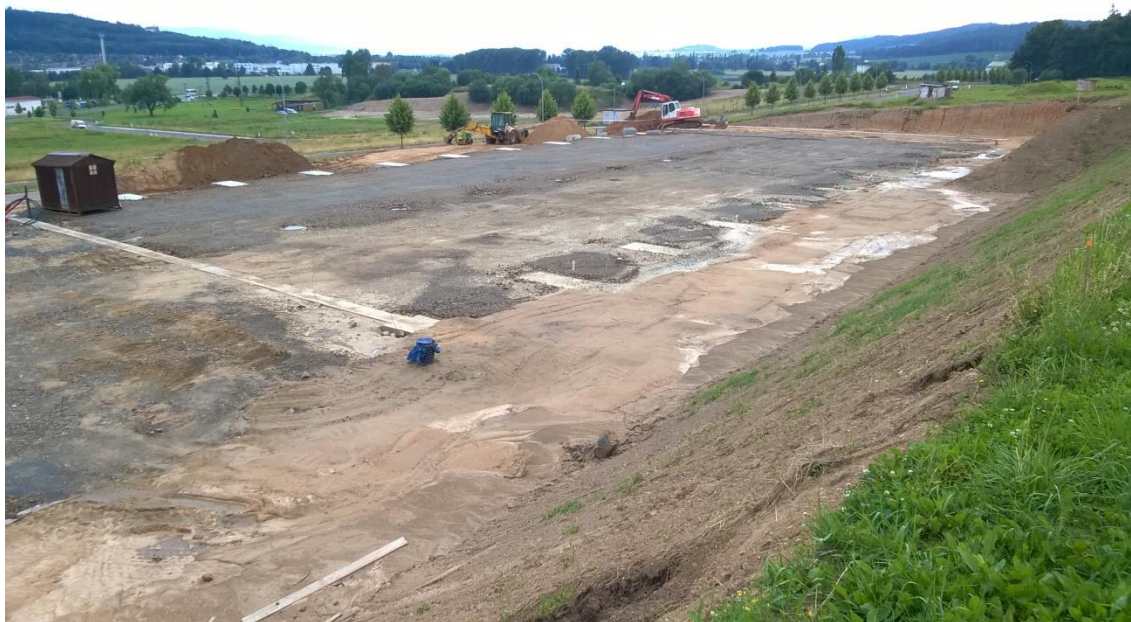
Obr. č. 12: Pozemek po hrubých terénních úpravách
