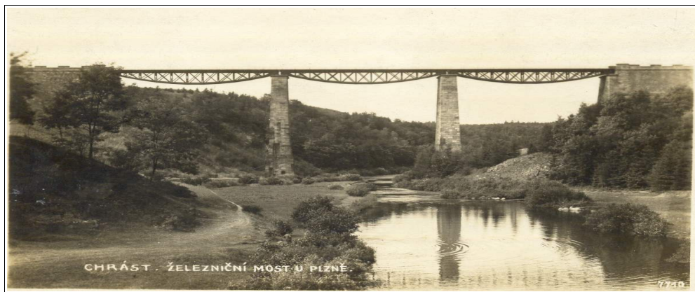
Obr. č. 18 – Železniční most v r. 1928 a v r. 2016
