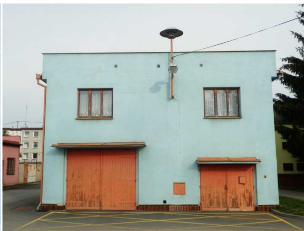
Obr. č. 27: Současná požární zbrojnice (r. 2016)
