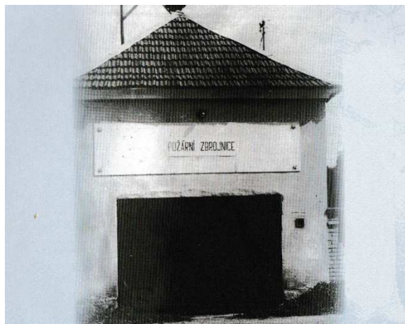
Obr. č. 26: Původní požární zbrojnice (r. 1953)
