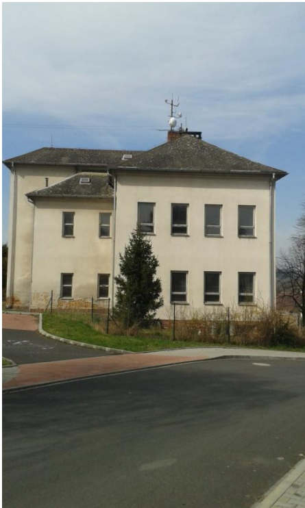
Příloha č. 1: Budova bývalé Obecní školy v Záluží
