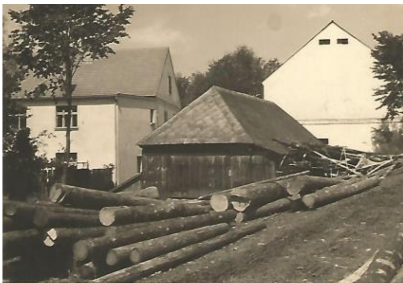
Obrázek č. 18: Podhrázský mlýn po rekonstrukci
