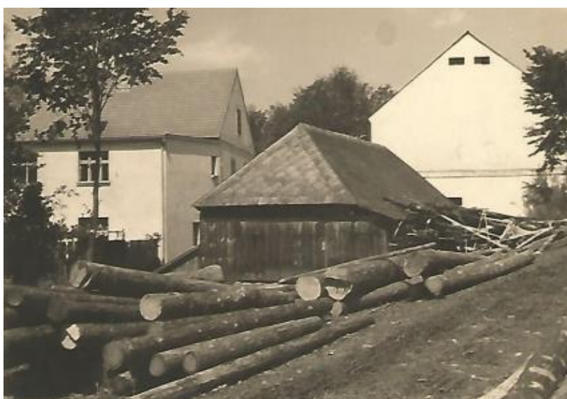
Obrázek č. 17: Podhrázský mlýn po rekonstrukci
