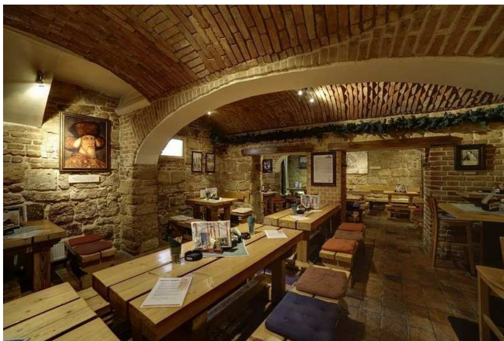
Interiér restaurace Uctívany Velbloud, strop - segmentové valené cihelné klenby (Americká 20, Plzeň)
