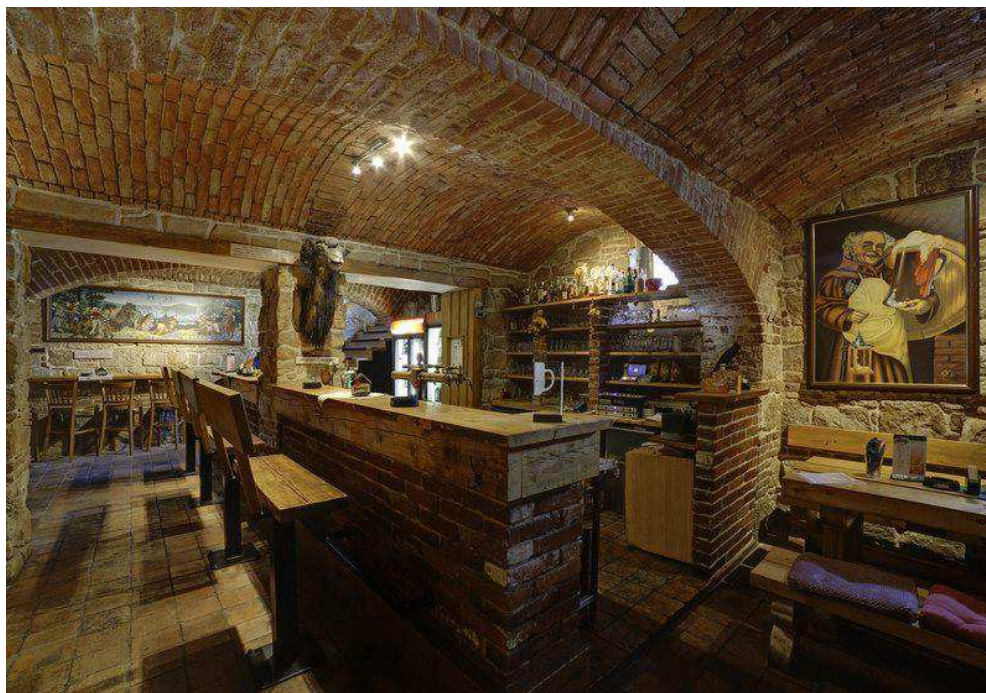
Interiér restaurace Uctívany Velbloud, strop - segmentové valené cihelné klenby (Americká 20, Plzeň)
