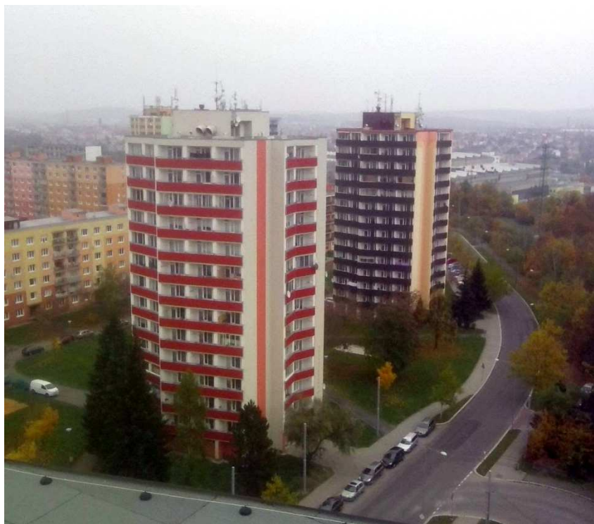
Atypické věžové domy vycházející ze systému PS69 (Heyrovského 54, Plzeň – Bory)
