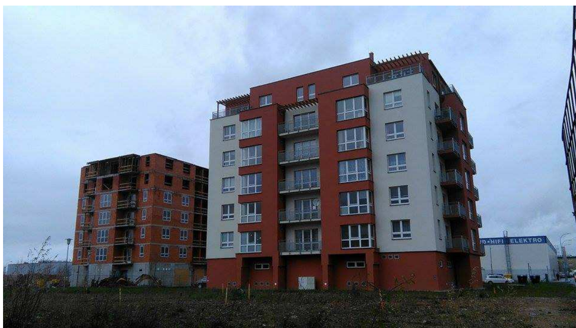
Dokončená a probíhající stavba bytových domů (Kaplířova ulice, Plzeň)
