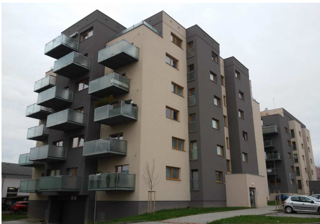
Šestice nových bytových domů (U Velkého rybníka 121, Plzeň)
