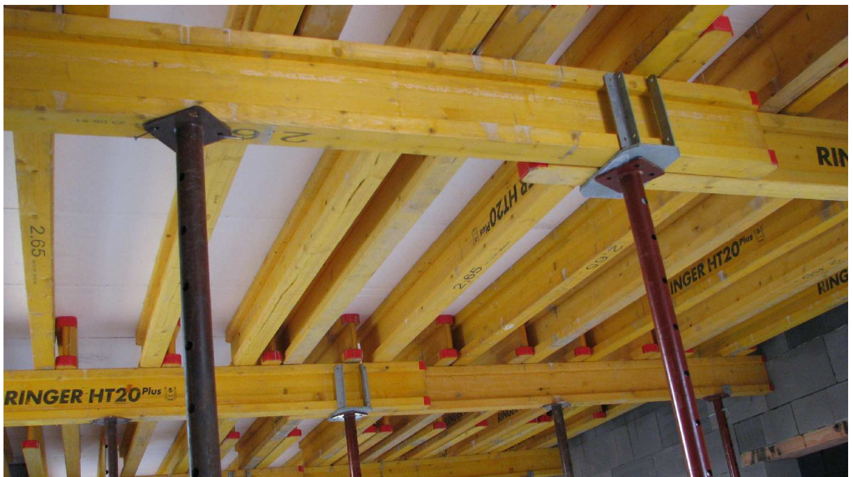
Obrázek 43 - Stropní bednění PERI
