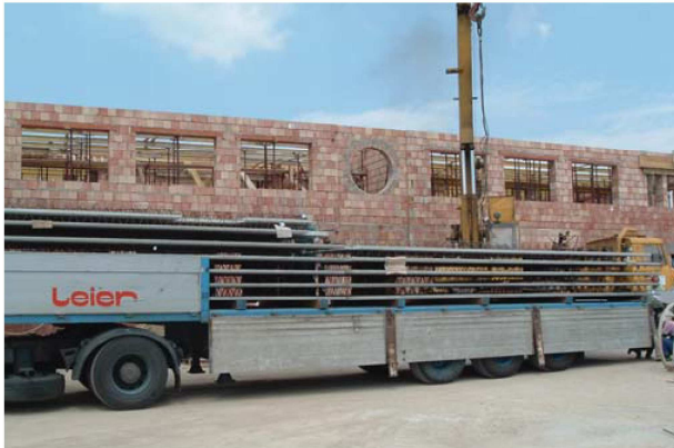
Obrázek 27 - Uložení nosníků na vozidle
