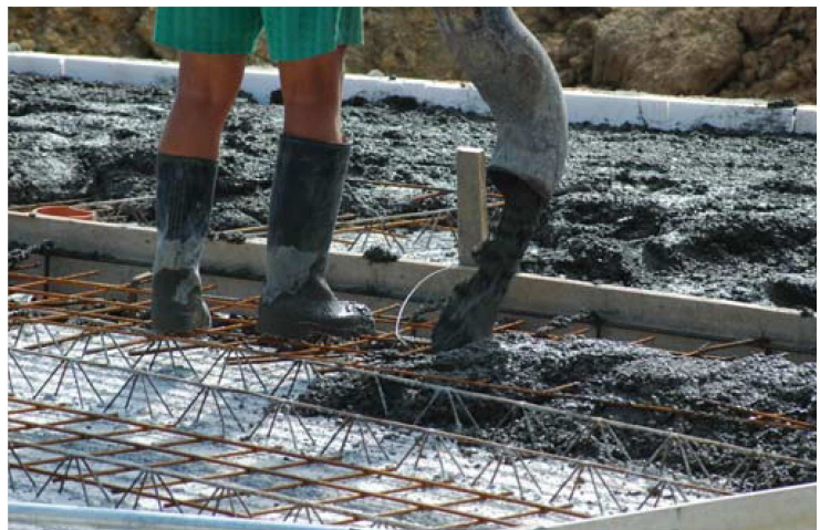
Obrázek 32 - Ukládání betonové směsi
