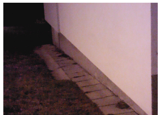
FLIR0230.jpg FLIR T620 55906046
