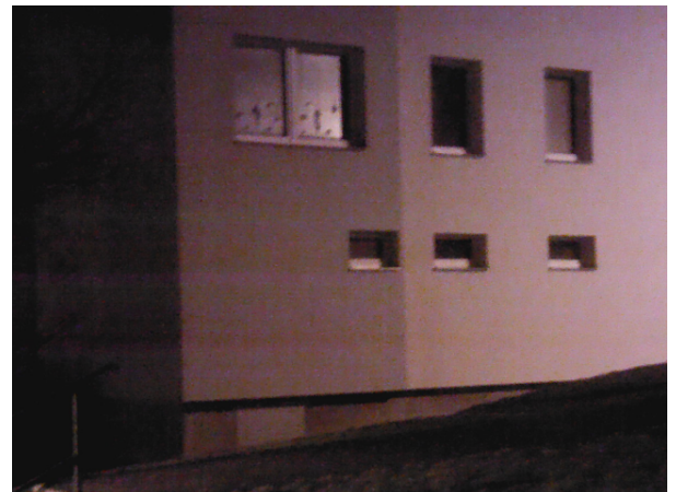
FLIR0221.jpg FLIR T620 55906046
