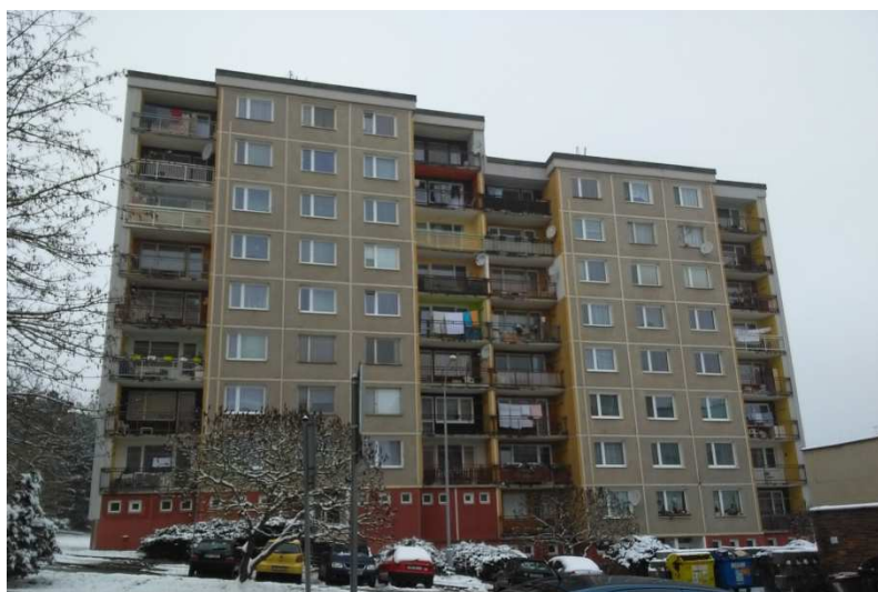
Obrázek 1: Panelová soustava PS 69, Plzeň Bolevec - západočeská varianta
