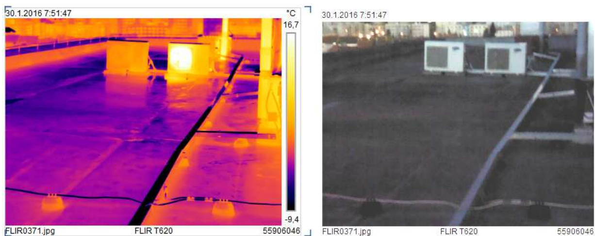
Obrázek 43: Termogram ploché střechy na panelovém domě ve Strakonících. Celkový pohled na střechu.
