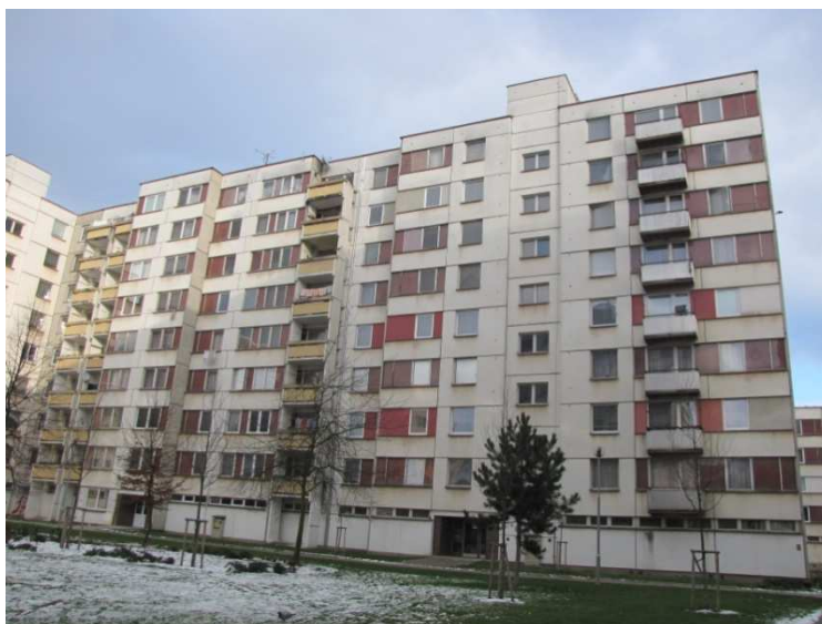
Obrázek 2: Stavební soustava PS 69/2 v Písku - jihočeská varianta
