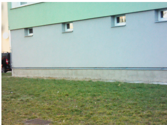
FLIR0403.jpg FLIR T620 55906046
