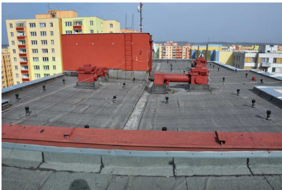
Obrázek 21: Zateplení střešního pláště foukanou izolací Climatizer Plus v Českých Budějovicích
