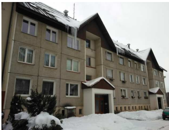
Obrázek 6: Varianta stavební soustavy PS 69 – sekce Šumava – západočeská varianta, se sedlovou střechou Železná Ruda
