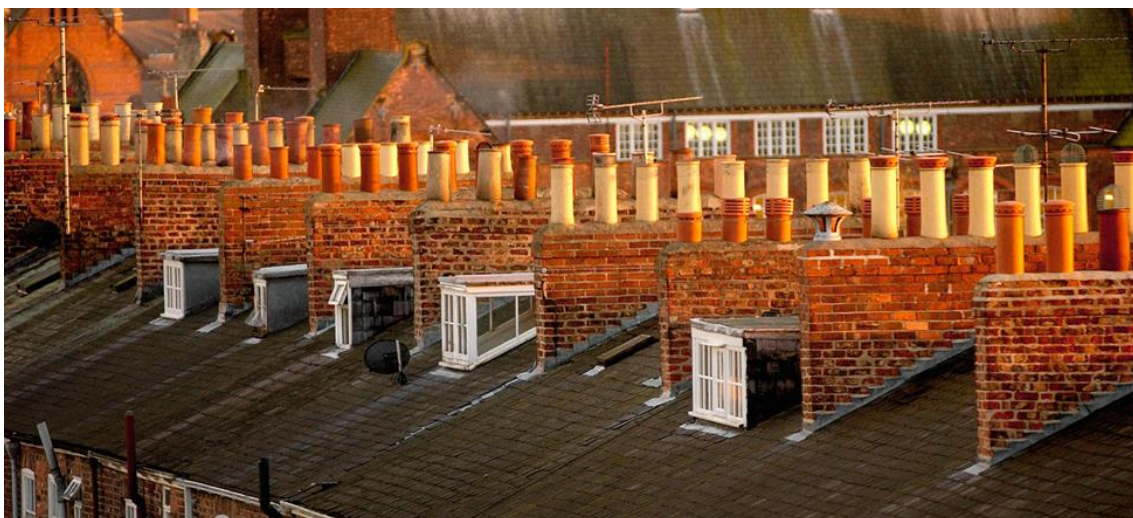
Obrázek 57: Pohled na střechu domu v UK s mnoha komíny, (66).
