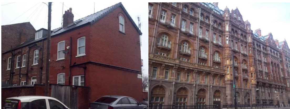
Obrázek 59: Externí odpadní a svodné potrubí na objektech v UK.
