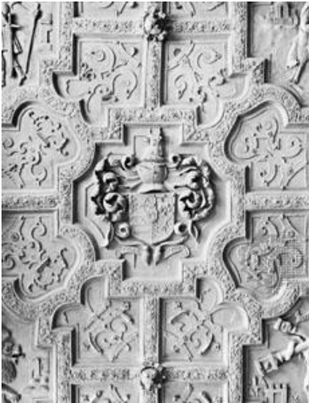
Obrázek 5: Příklad prvku „strapwork“, strop v objektu Long Gallery, Blicking Hall, Norfolk, Anglie, 1626. (14)
