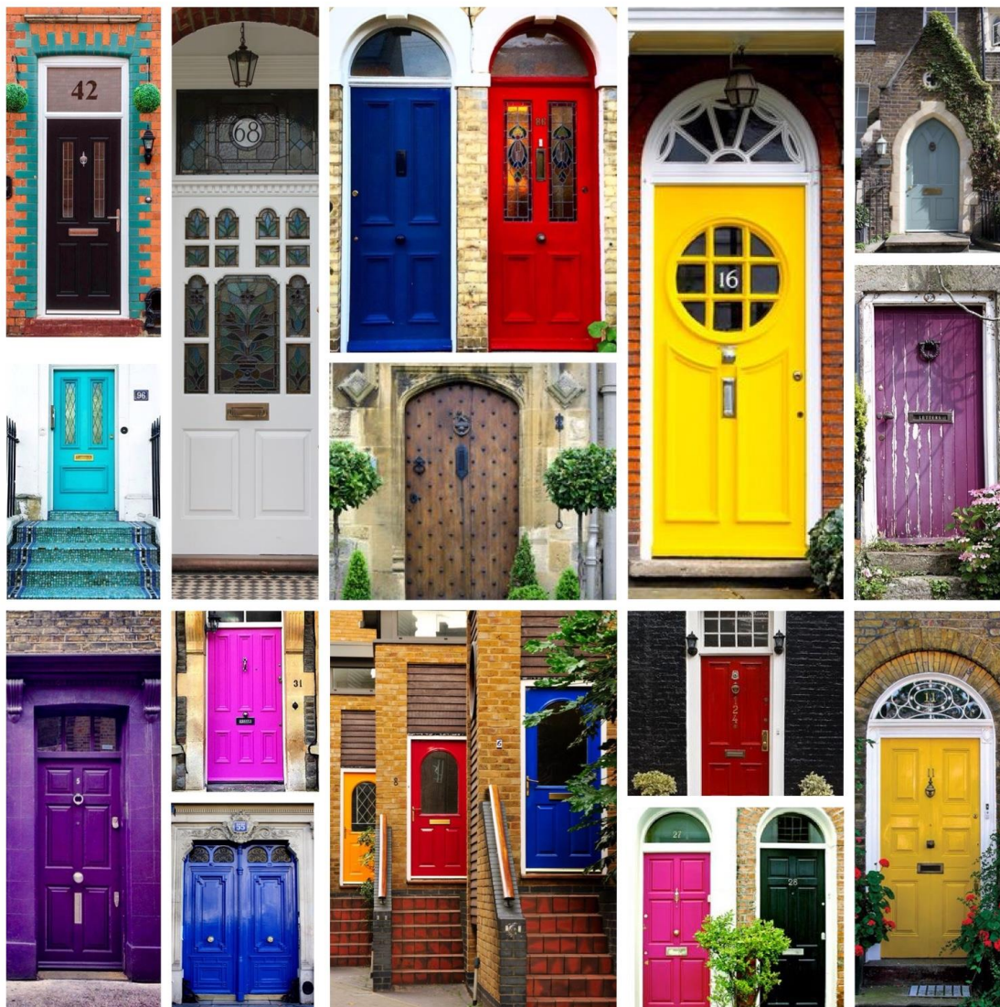
Obrázek 23: Příklady vchodových dveří v UK. Typická je jejich barevnost, zdobená klepadla, drážky na dopisy, použití nadsvětlíků, portálů, (37).
