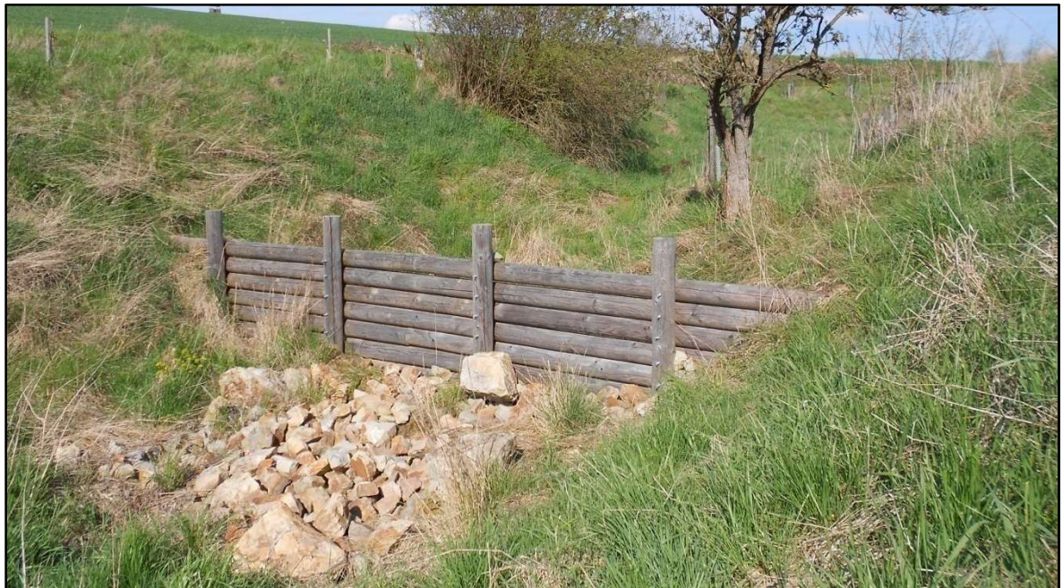
Obrázek 2.12: Přehrážky slouží ke zpomalení odtoku vody. Na foto PŘE 10N.
