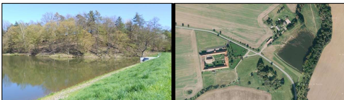
Obr. 2.8: Vodní nádrž Býkov (pohled za západního kraje hráze) a aktuální ortofoto nádrže Býkov vedle statku Býkov.
