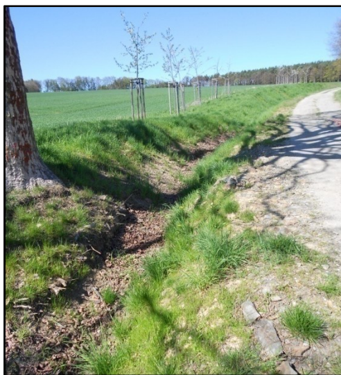
Obr. 2.14: Svodný příkop PŘ 4N.
