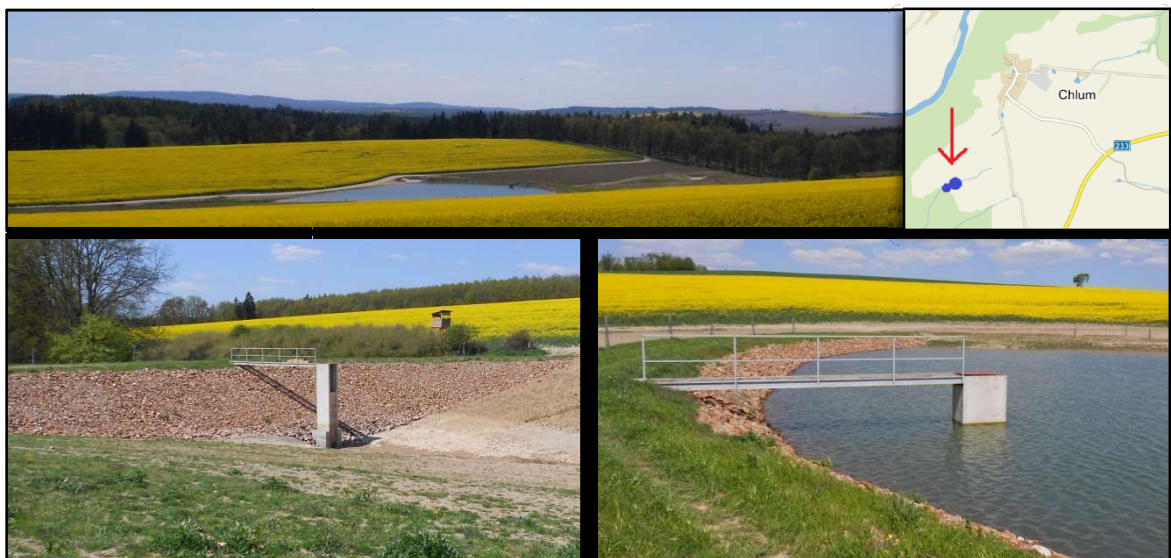
Obrázek 2.29: Soustava dvou vodních nádrží Čeněk 1 a Čeněk 2, slouží k zadržování vody ve svažitém území. Na pravé dolní fotografii je první průtočná nádrž, do které vtéká jeden z přítoků řeky Radubice. Po naplnění první nádrže voda nateče do druhé (fotografie vlevo dole), která je zatím prázdná, a poté voda teče dál svým korytem.
