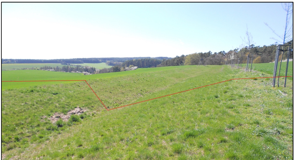
Obr. 2.10: Průleh PO 1N po dokončení. Červeně je znázorněn příčný řez průlehu PO 1N a PO 2N.
