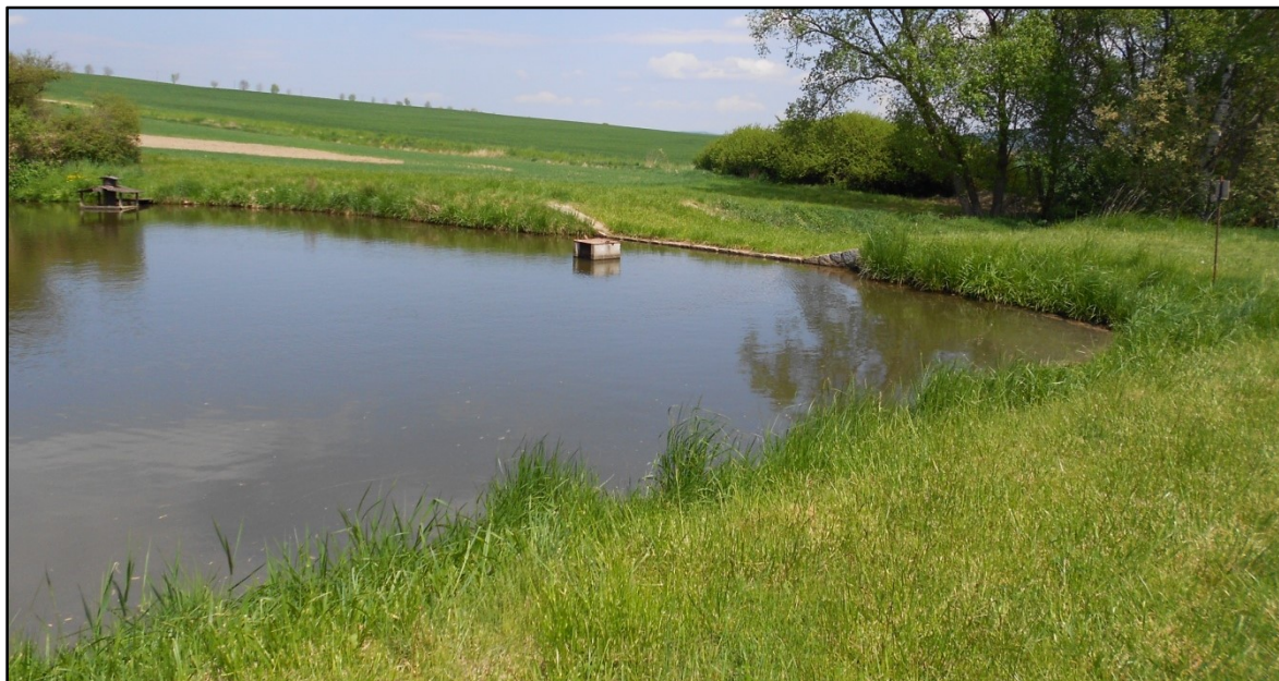
Obrázek 2.27: Zrekonstruovaná vodní nádrž VN1. Před rekonstrukcí měla nádrž protrženou hráz.
