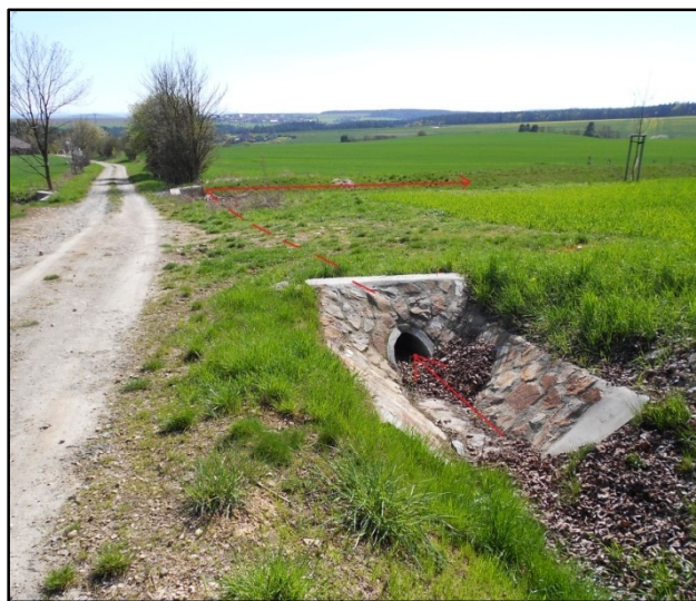
Obrázek 2.15: Vyústění svodného příkopu do záchytného průlehu.
