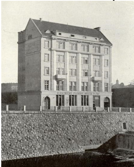
Obrázek 2: Budova ředitelství PMDP "Hydro" s vodní elektrárnou na Denisově nábřeží 12
