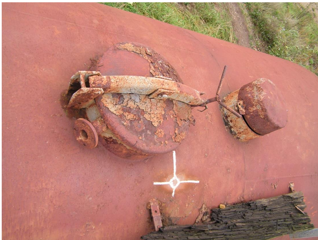
Horní část cisterny v okolí dvou přírub. Křídou je vyznačena poloha pro čidlo P3.
