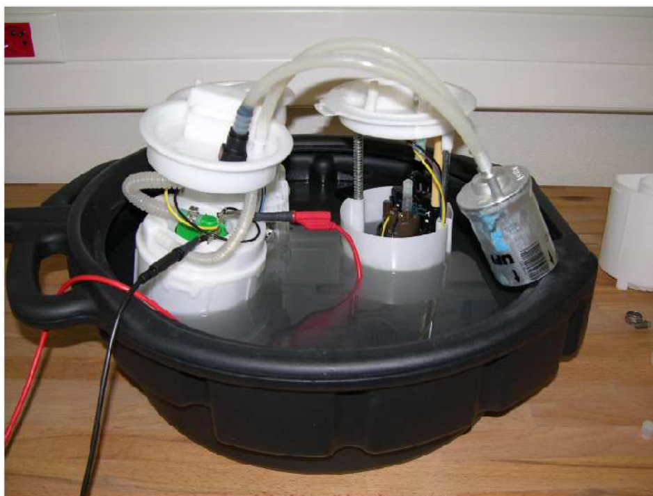
Obr. 56: Zapojení čerpadla při navození závady mimo vozidlo
