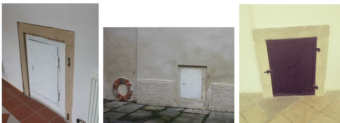
Obr. 3.8: Pozůstatky topných otvorů v interiéru západního křídla zámku (vlevo), vnější strany východního křídla (uprostřed) a vzor pro rekonstrukci topného otvoru nacházející se v zámecké části kláštera Kladruby (vpravo).
