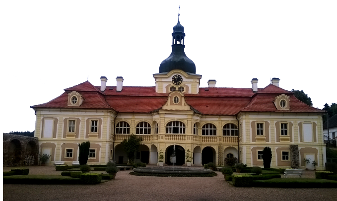
Obr. 3.5: Zámek Nebílovy jako vzor pro rekonstrukci věže barokní podoby zámku Hradiště.
