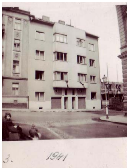
a) původní stav po dokončení
