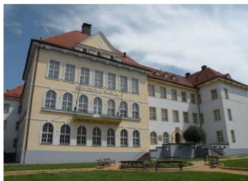
b) 2012- současný stav po rekonstrukci
