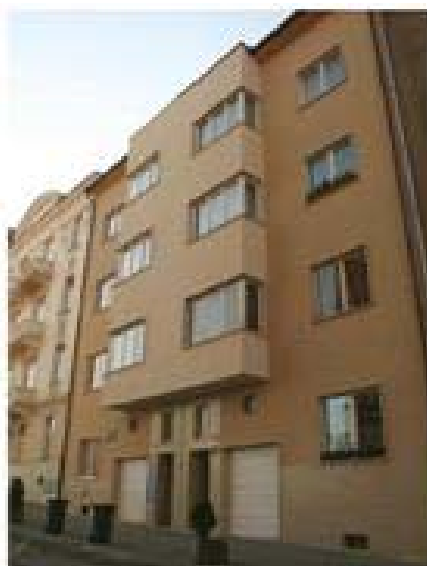
b) stav po rekonstrukci fasády 2010
