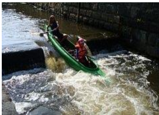
Obrázek 8 – Propust Kynšperk nad Ohří
