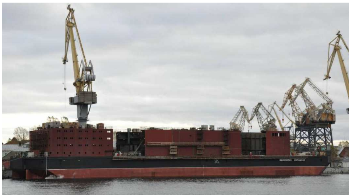
Obr. 4. Plovoucí jaderná elektrárna ve výstavbě [30, str. 7].
