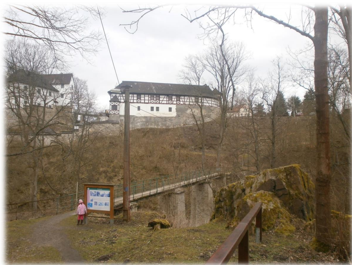
Příloha 36: Most pod hradem Seeberg, který spojoval obě části vesnice 93
