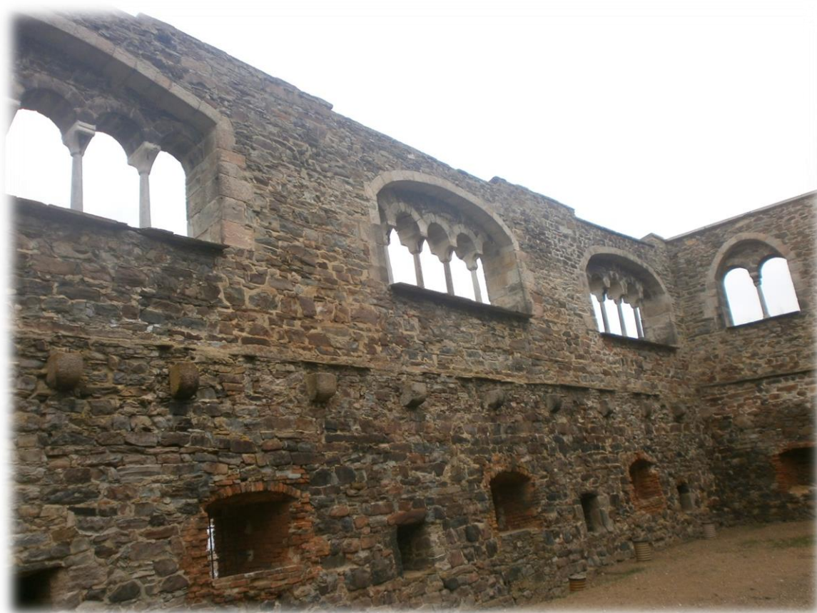
Příloha 5: Pozůstatky hradního paláce na chebském hradě s arkádovými okny 62
