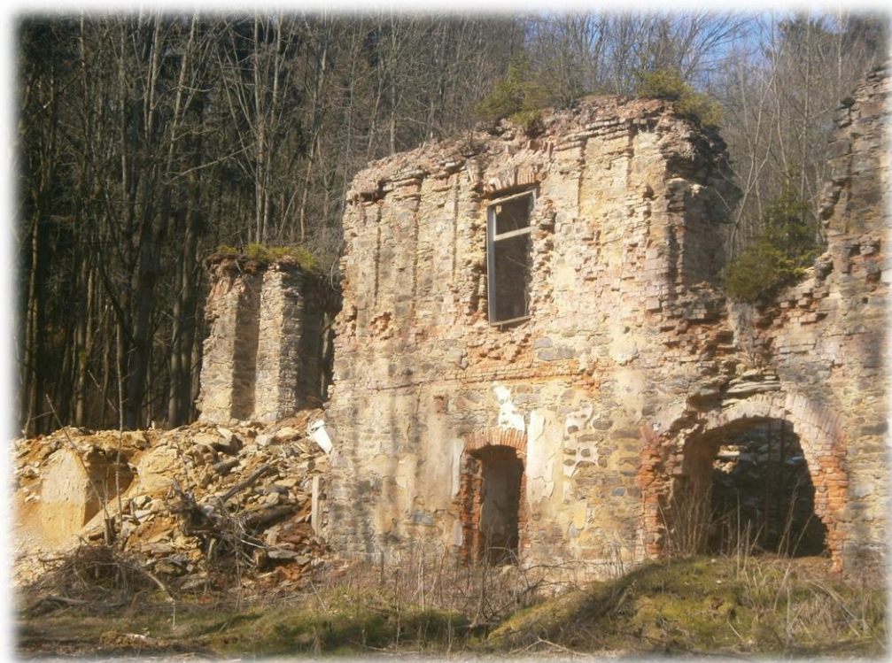
Příloha 26: Zřícenina zámku v Horních Lubech, pohled z boku budovy 83
