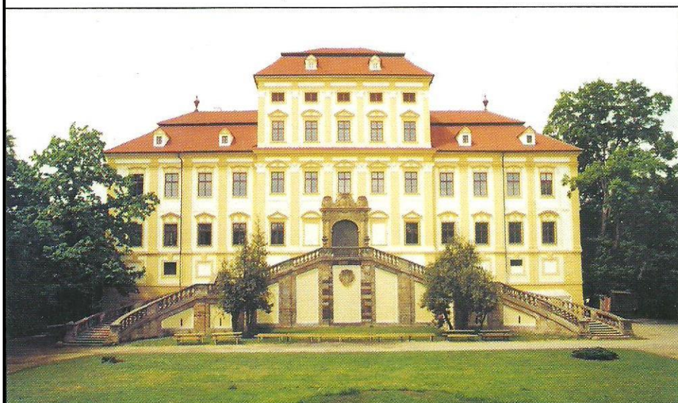
Červený Hrádek po opravě Rothenhaus nach der Reparatur
