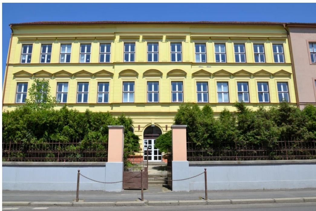
Příloha č. 15: Vchod do budovy ZŠ, dříve vchod pro dívky a chlapce měšťanských škol 406
