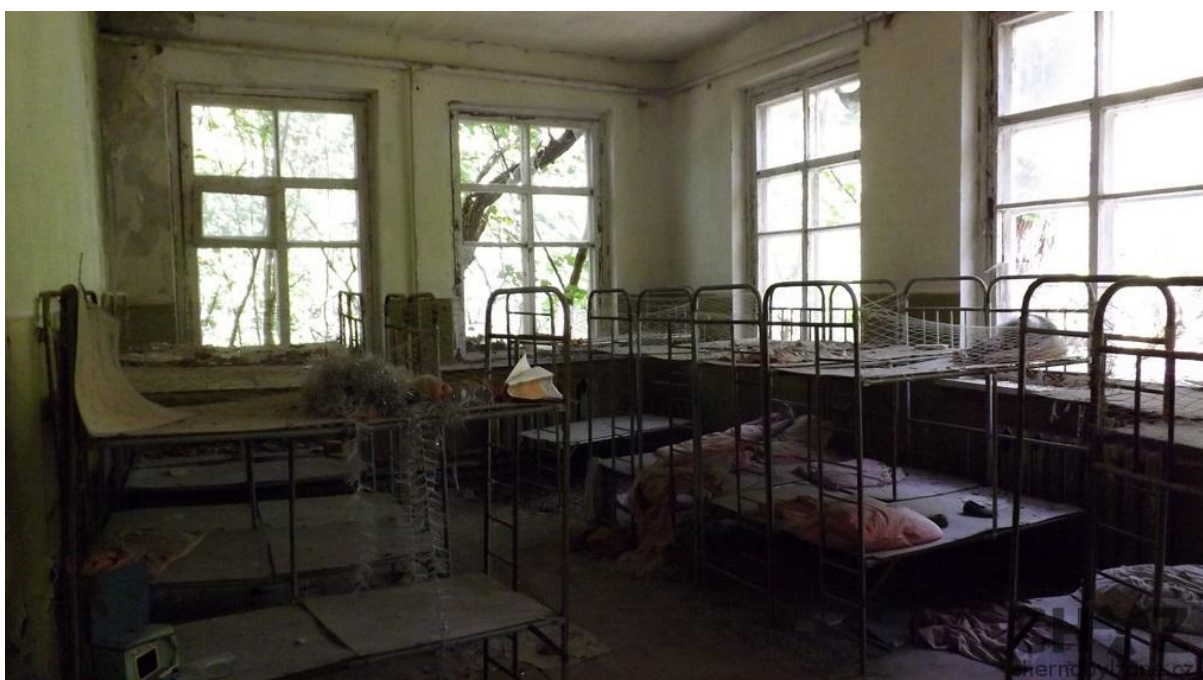
Obrázek 9- Budova bývalé školky v obci Kopači
