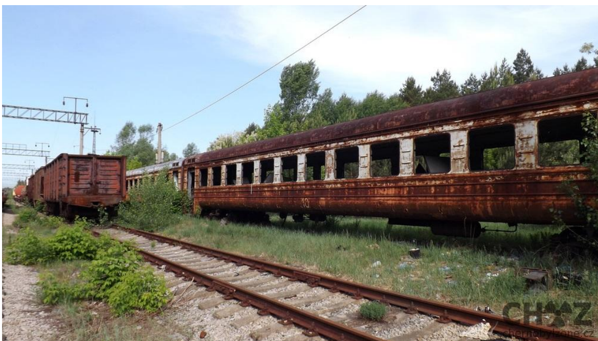
Příloha 8- Janov- železniční stanice (dostupné z: http://chernobylzone.cz/foto-cernobylska-exkurze-2013/nggallery/page/5 )
