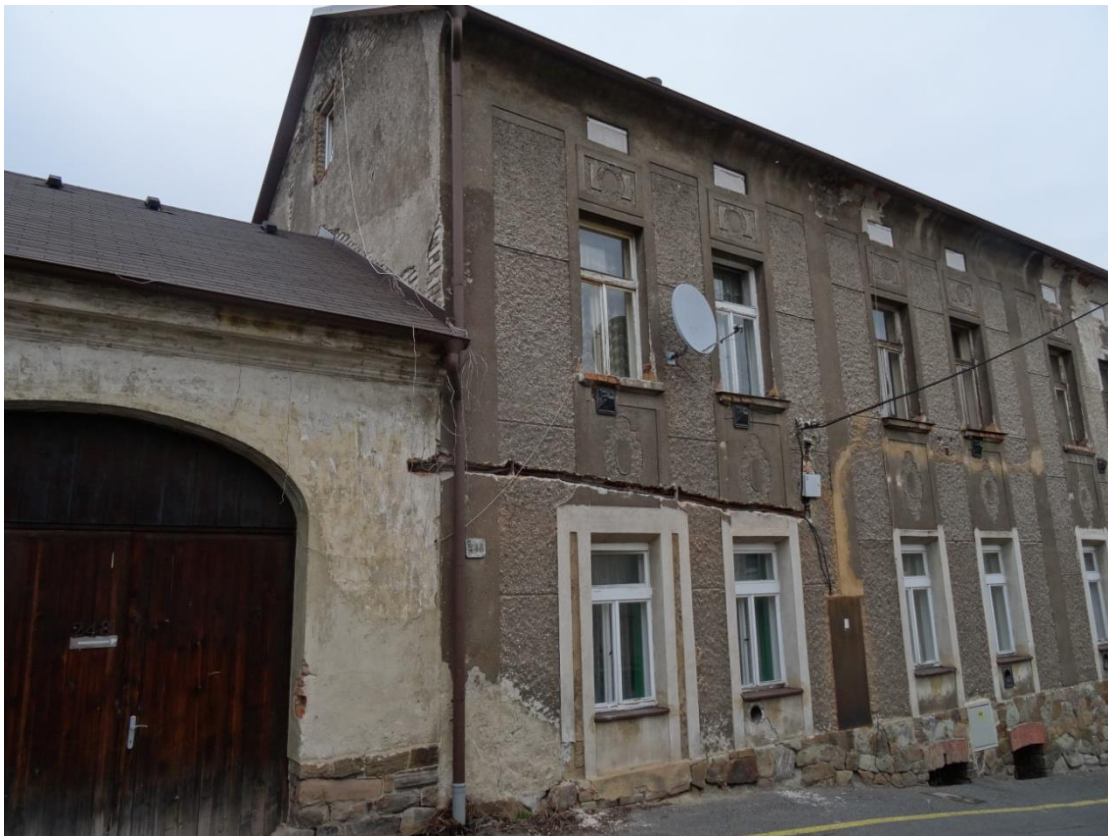
17) budova bývalého sídla NSDAP v Hořovicích, č. p. 248
