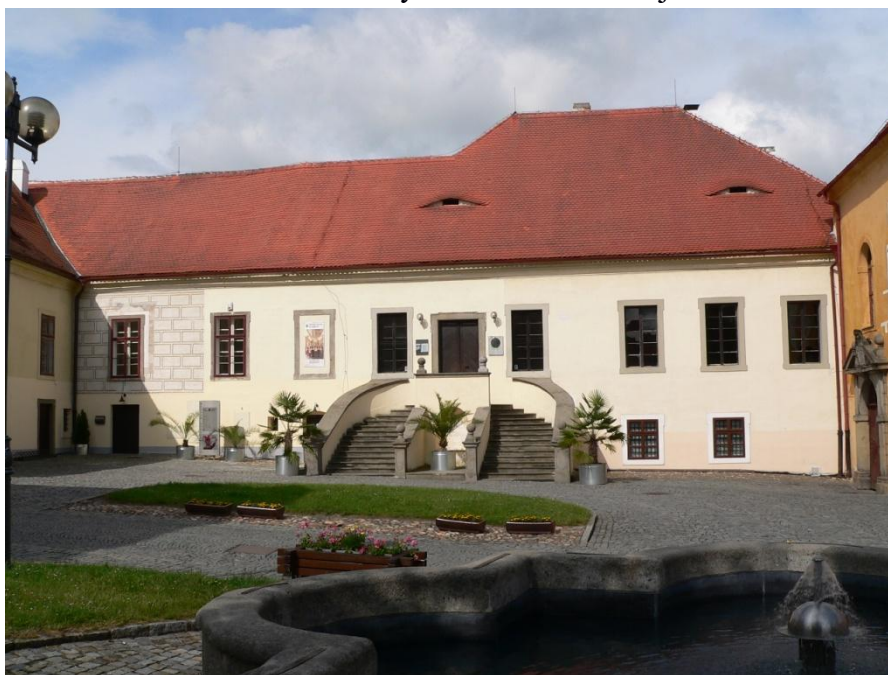
Obr. 10. – Pohled na jihozápadní křídlo.
