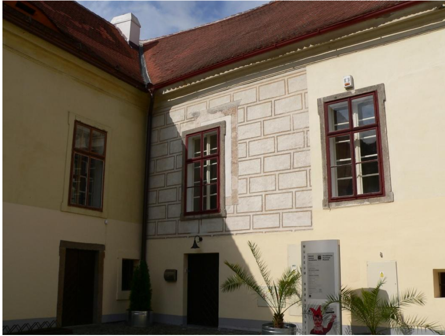
Obr. 11. – Detailní pohled na sgrafitovou výzdobu jihozápadního křída.
