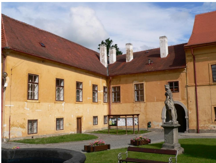
Obr. 5. – Návaznost severní vstupní budovy na zámecké jádro (levá část fotografie).
