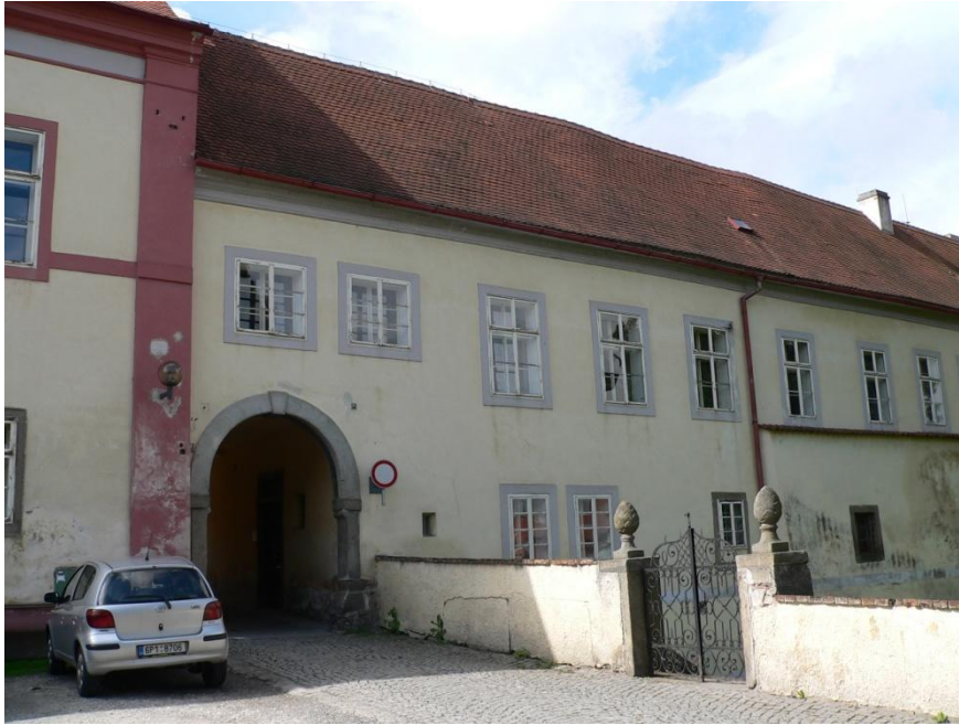
Obr. 1. – Pohled na severní průčelí.
