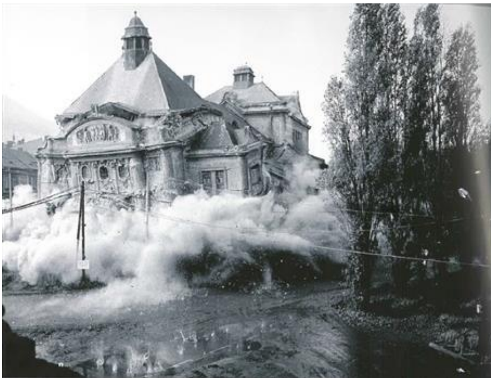
Obrázek 15 - odstřel starého divadla
