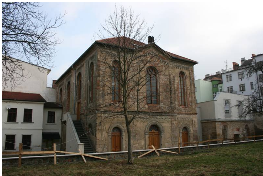
10.13. Stará synagoga v Plzni před rekonstrukcí. Převzato z: Stará synagoga. Město Plzeň. [online]. [cit. 2016-04-06]. Dostupné z: http://www.kostelycz.cz/foto/59ss.jpg
