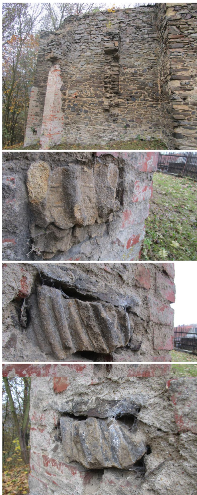
Obr. 36. Zazděné fragmenty kamenných architektonických detailů v opěracích presbytáře
