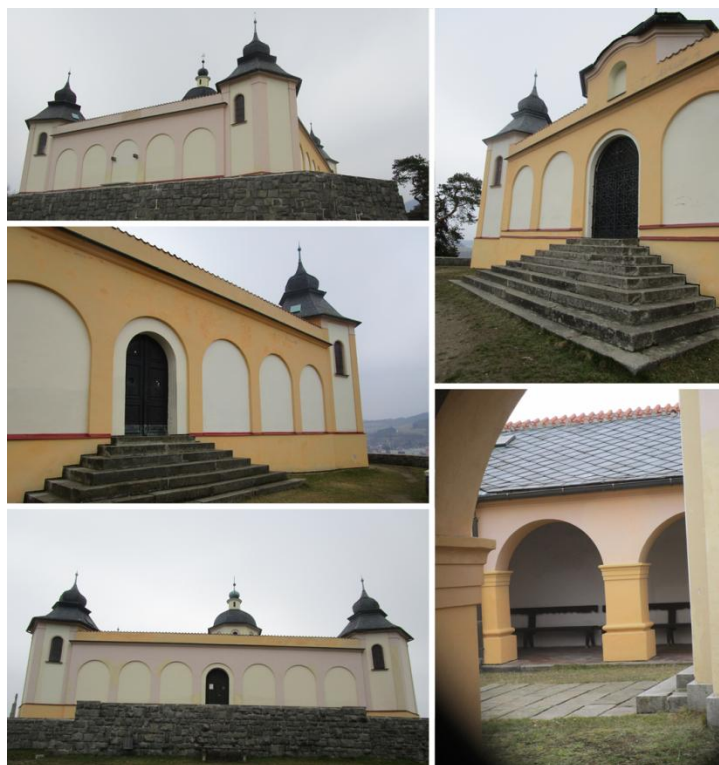
Obr. 59. Fotografická dokumentace současného stavu
