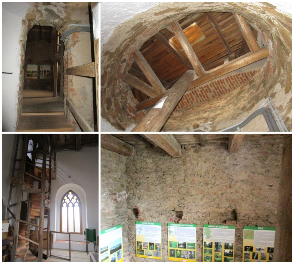
Obr. 88. Interiér kostela a vybrané detaily
