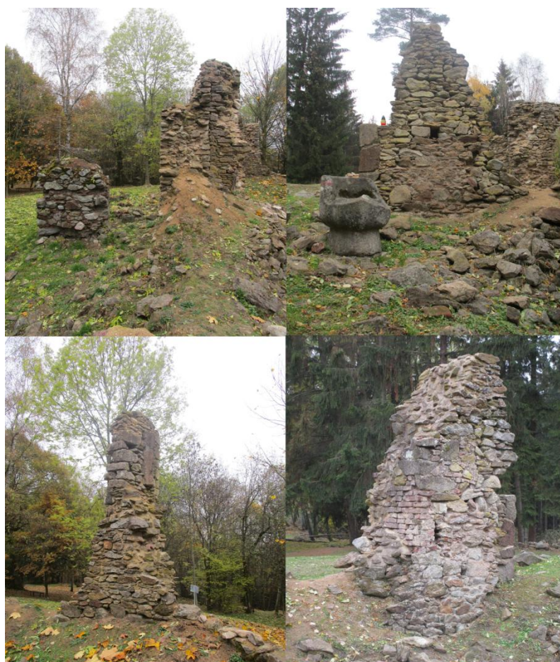
Obr. 7. Relikty levé strany věže, odsazení presbytáře a sakristie, křtitelnice a zdivo lodi, relikty pravé strany věže
