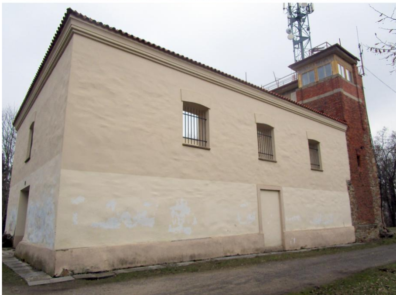
Obr. 26. Obvodové zdi hlavní lodi se zadržnými vstupy
