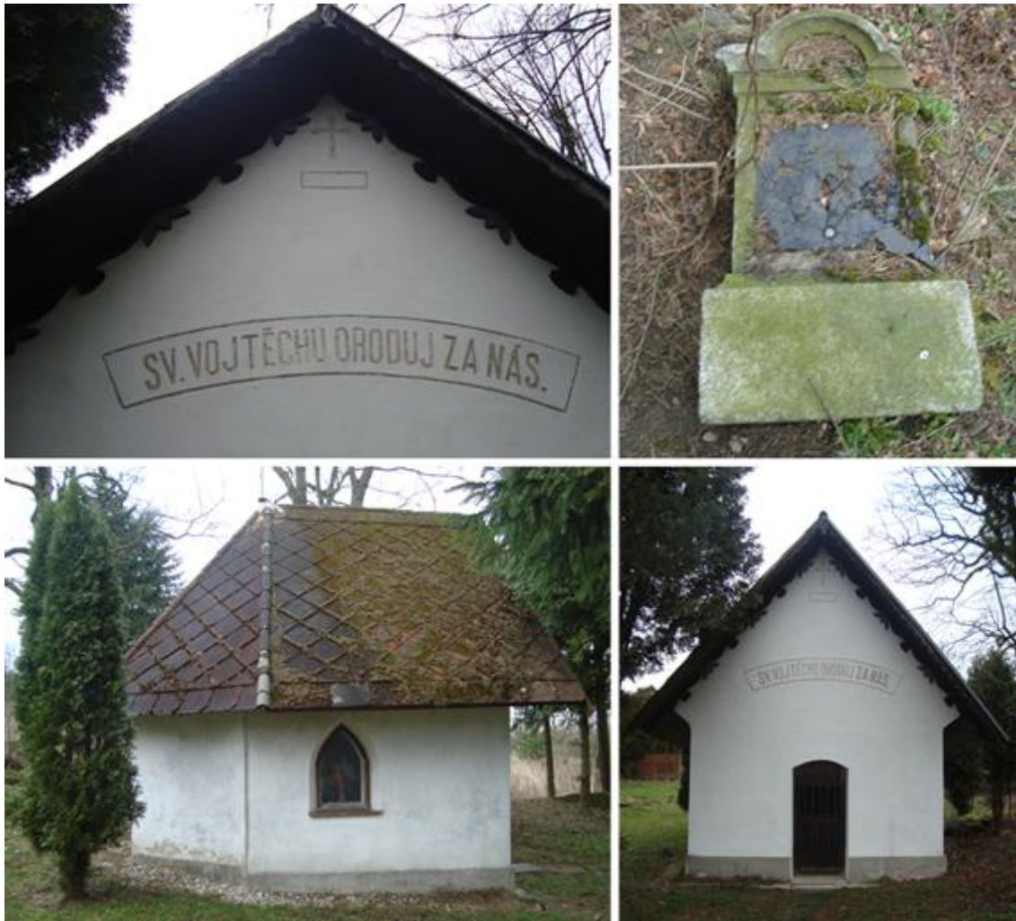
Obr. 71. Fotografická dokumentace kaple
