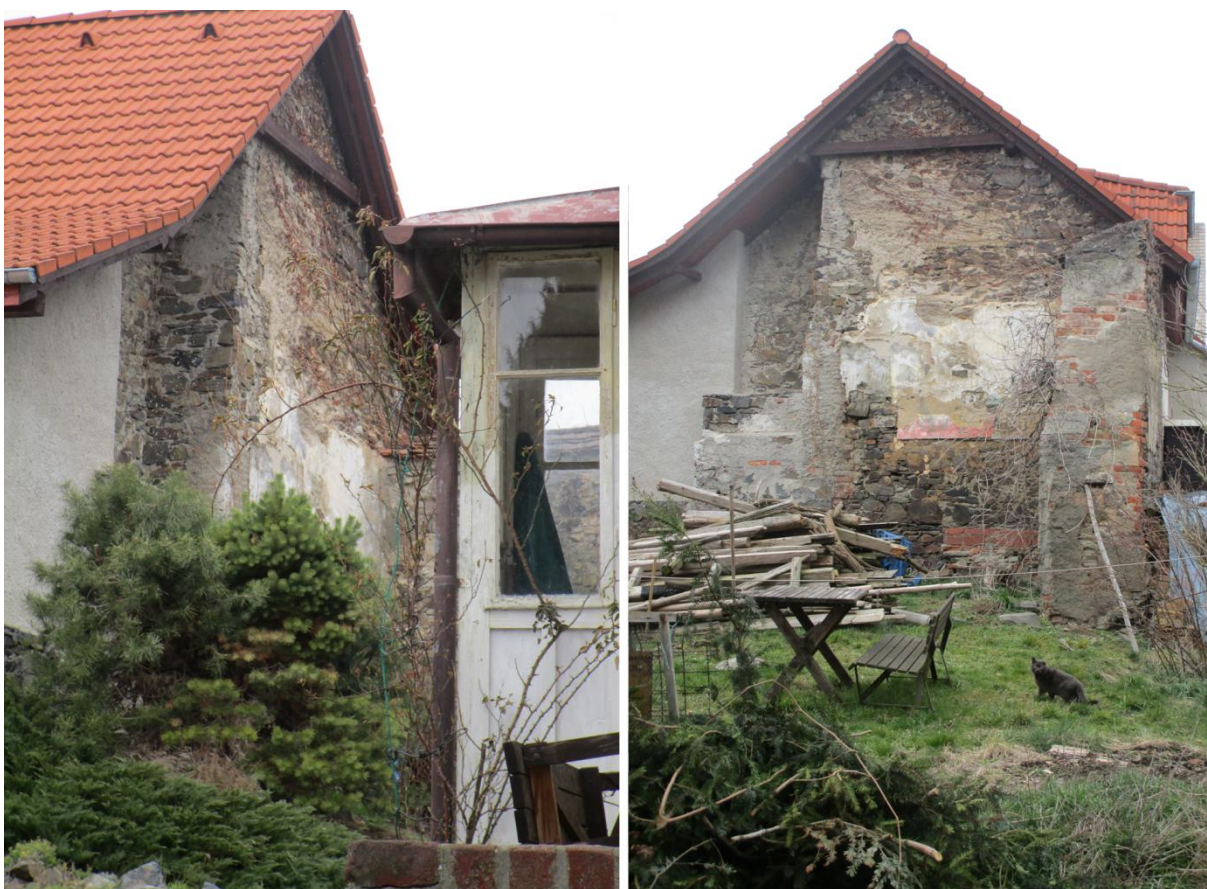
Obr. 30. Fotografická dokumentace současného stavu
