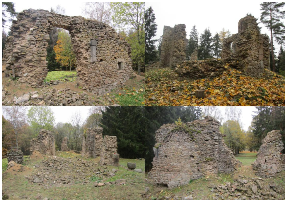
Obr. 6. Pohled do hlavní lodi, levá strana presbytáře, presbytář, pravá strana presbytáře
