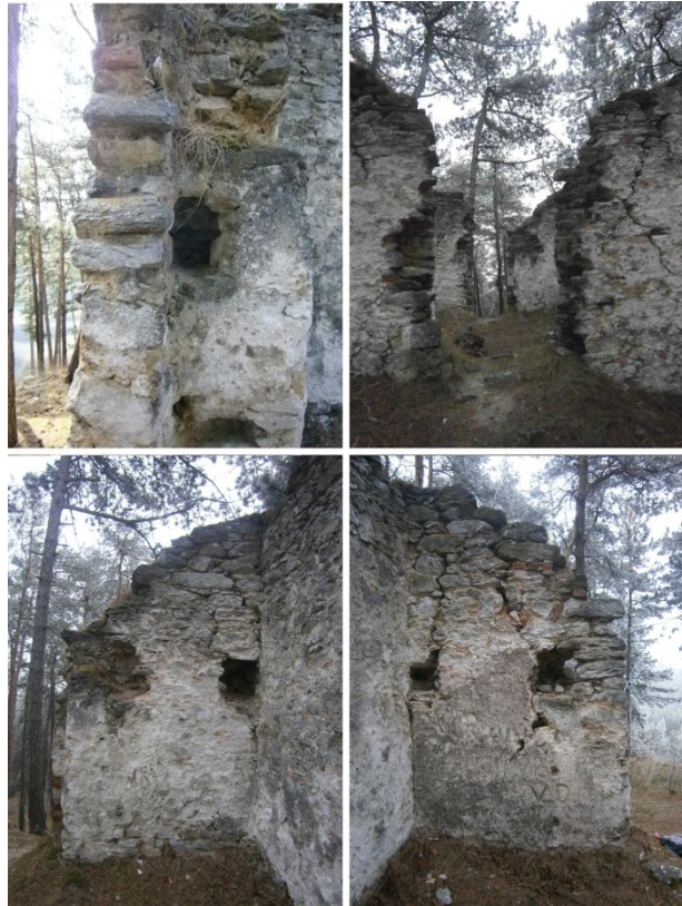
Obr. 53. Hodnotné architektonické detaily
