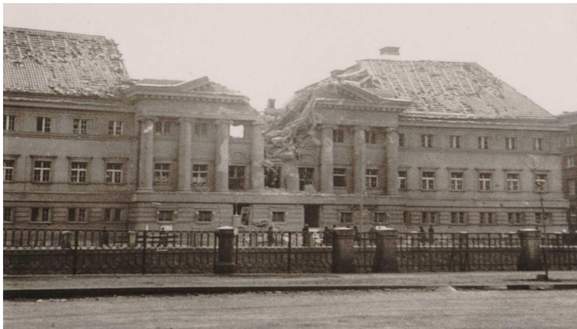
Obrázek č. 3 – Poškození lázní během bombardování Plzně r. 1944
