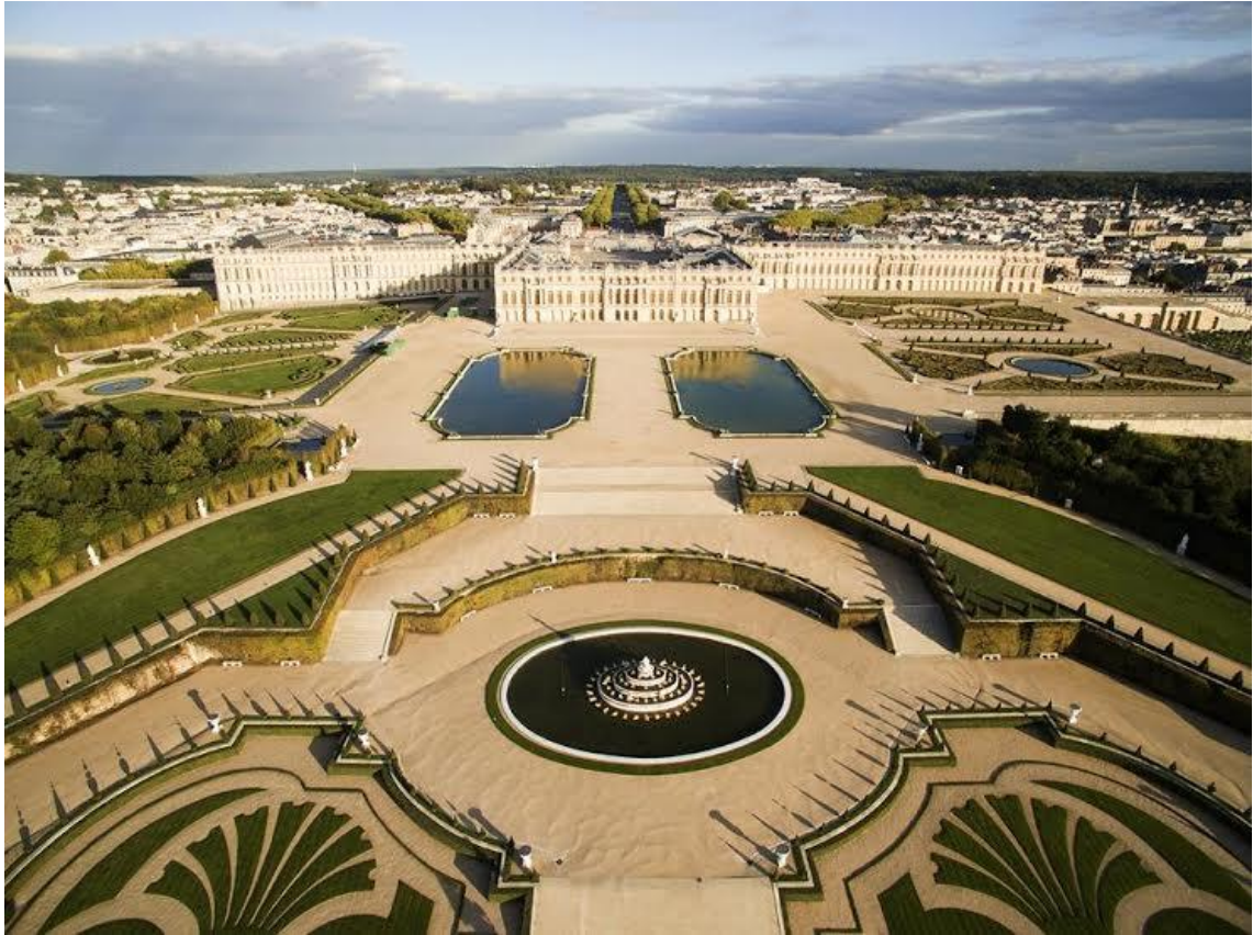
Image 4: Vue aérienne du Bassin de Latone et du Parterre d'Eau avec un arrière-plan du château et du Parterre du Nord à gauche et du Parterre du Midi à droite [35]
