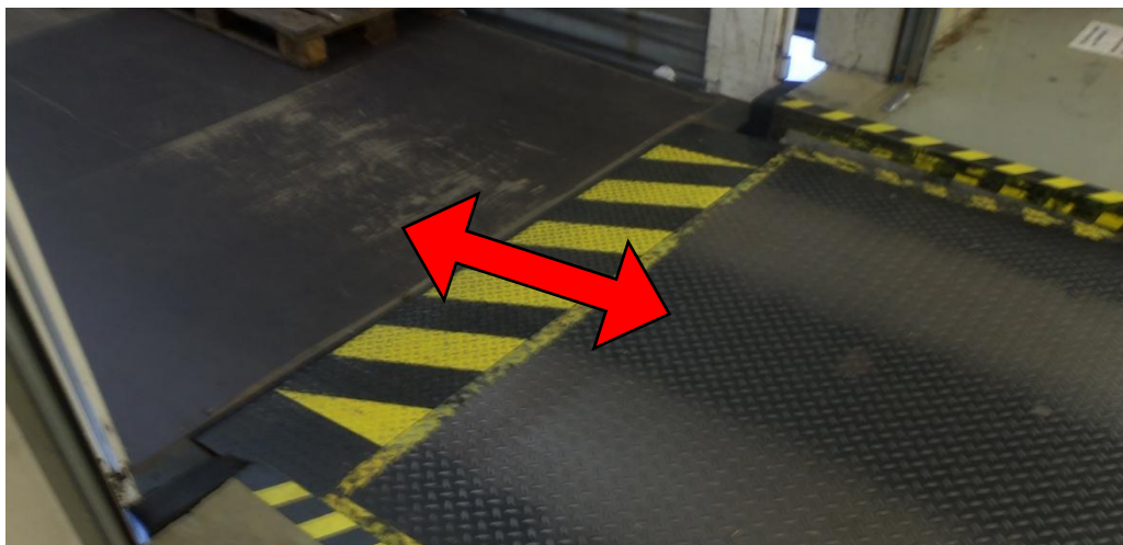
Obr. 3-15 Rampa se slízkovým plechem
