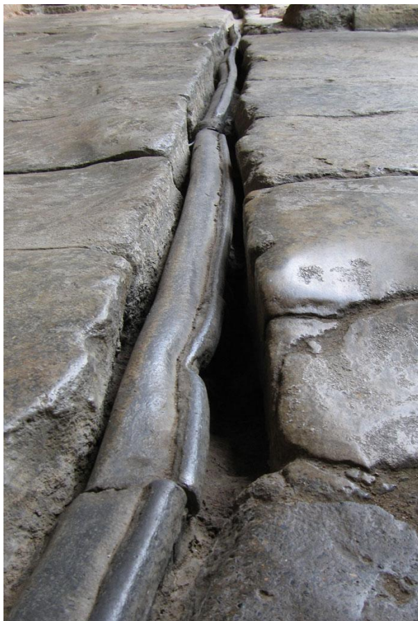
Obrázek 3-1 Římské olověné potrubí [13]
