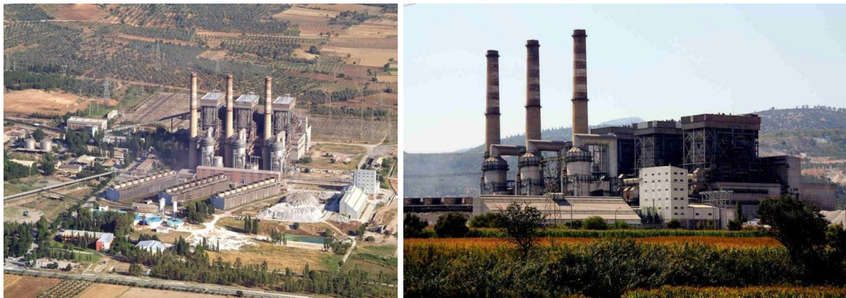
Obrázek č. 1: Fotografie elektrárny Yatagan.
