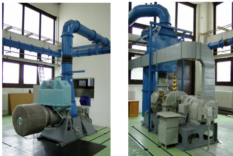
Obrázek 3: Fotografie vzduchové turbíny (vlevo) a kompresoru (vpravo) [4]
