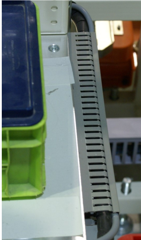
Obr. 4.12 Nové vyvedení kabelů a zabezpečení kabelovým žlabem
