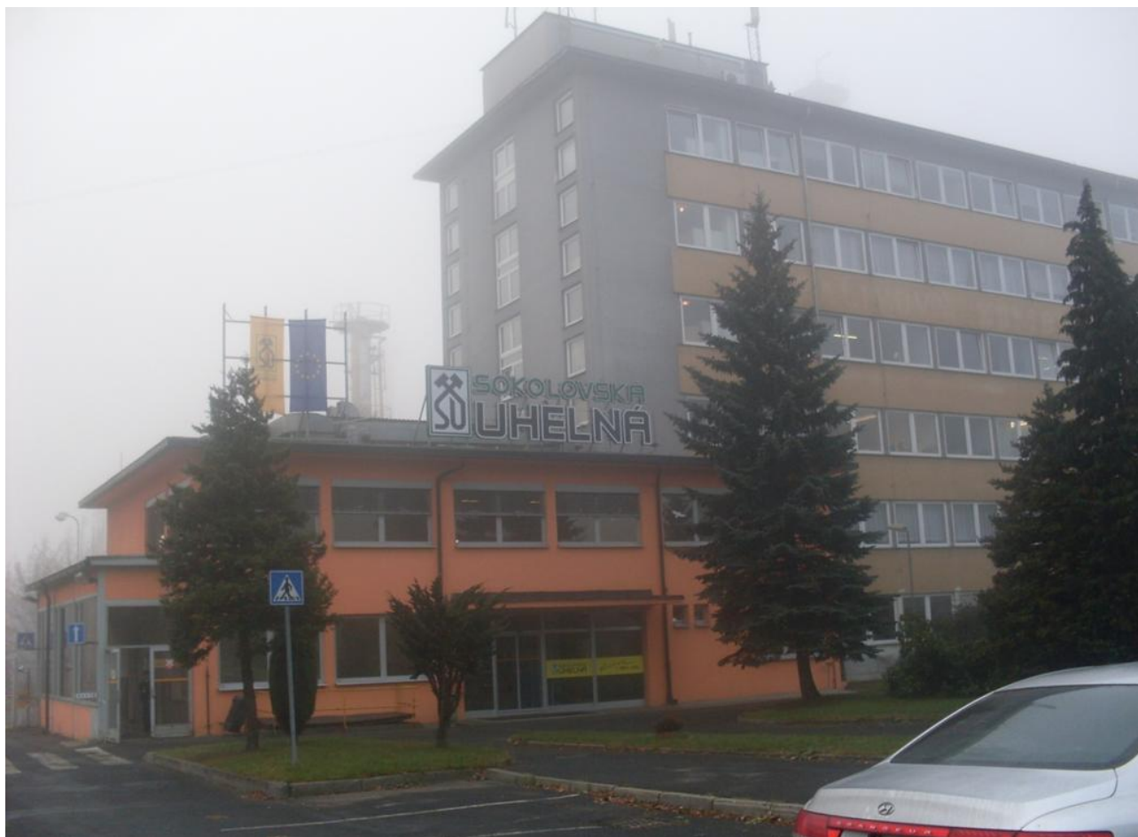
Obr. 3.1 Vrátnice Vřesová Sokolovská uhelná
