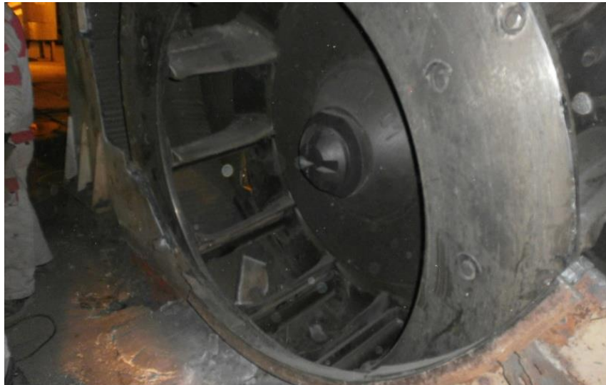
Obr. 4-4 – Porucha – poškozená hřídel soustrojí VM 94 [47]
