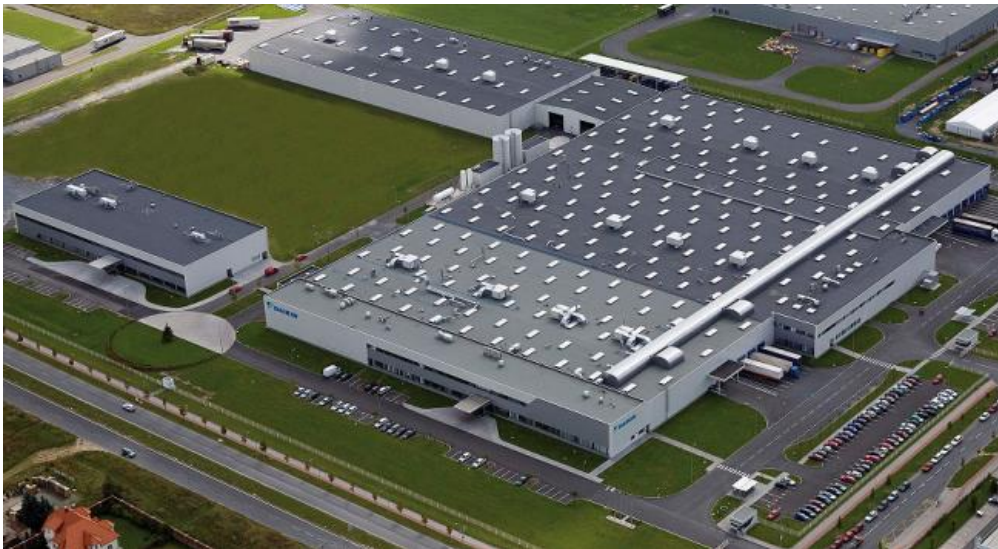
Obr. 3-2 Pohled na výrobní areál DICz [14]
