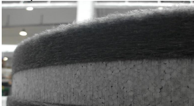
Obrázek 6-14 Izolace víka pro variantu s EPS. [Zdroj vlastní]
